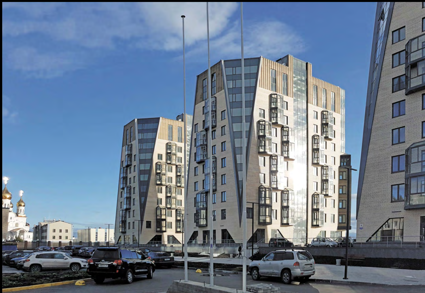
Застройка пешеходной набережной: Жилой комплекс «Альфа» Архангельск, наб. Северной Двины (2013)
