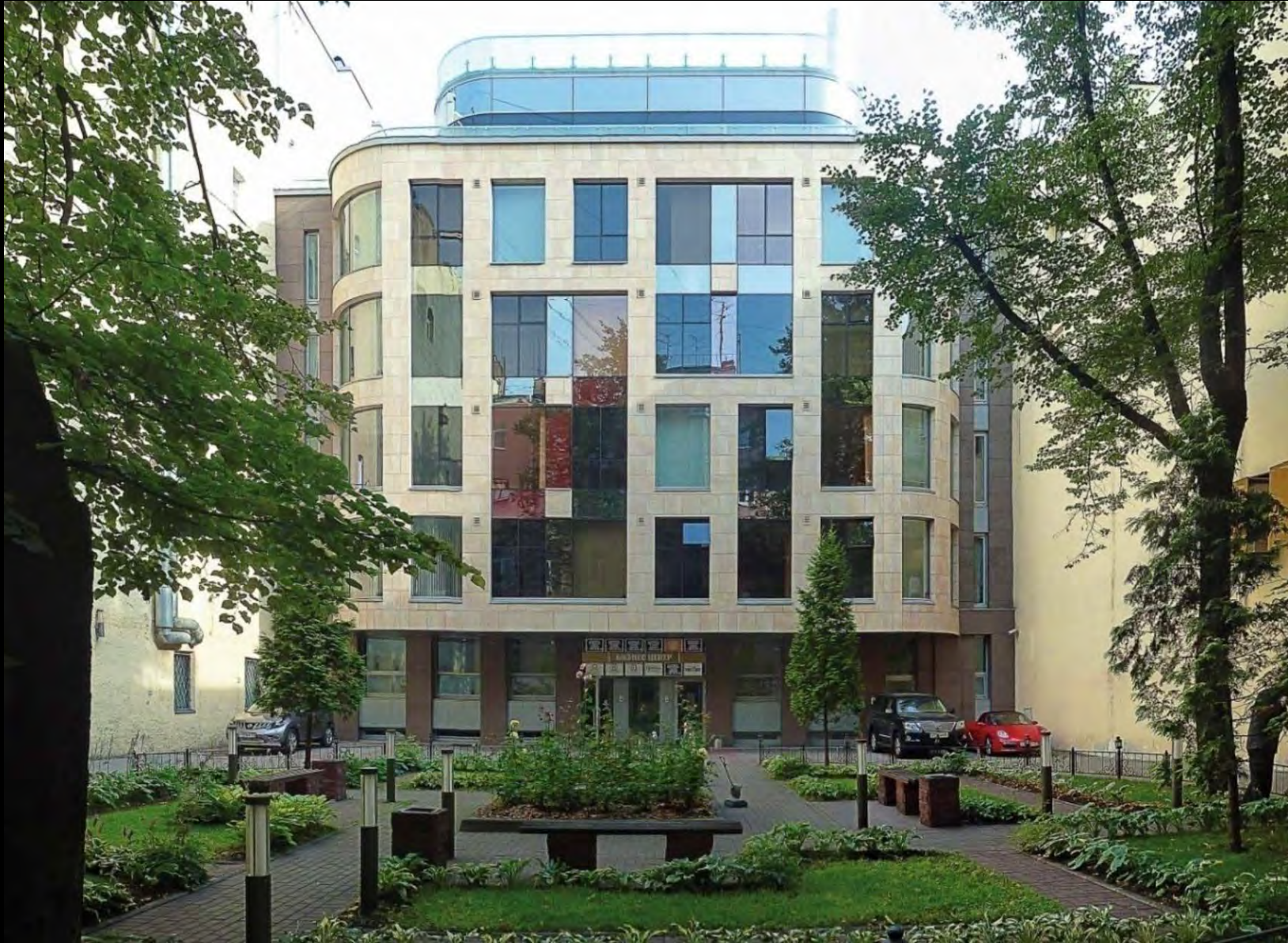
Административное здание Центральный район, ул. Чайковского, 44 (2007)
